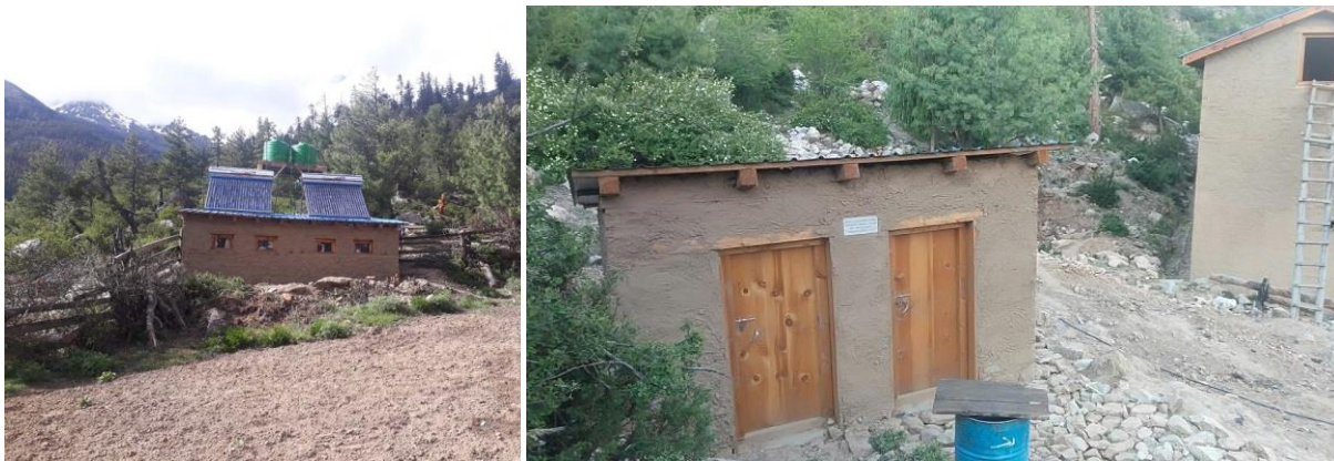
Huset med fyra duschkabiner. De nya toaletterna vi gaveln av den ena sovlängan.
