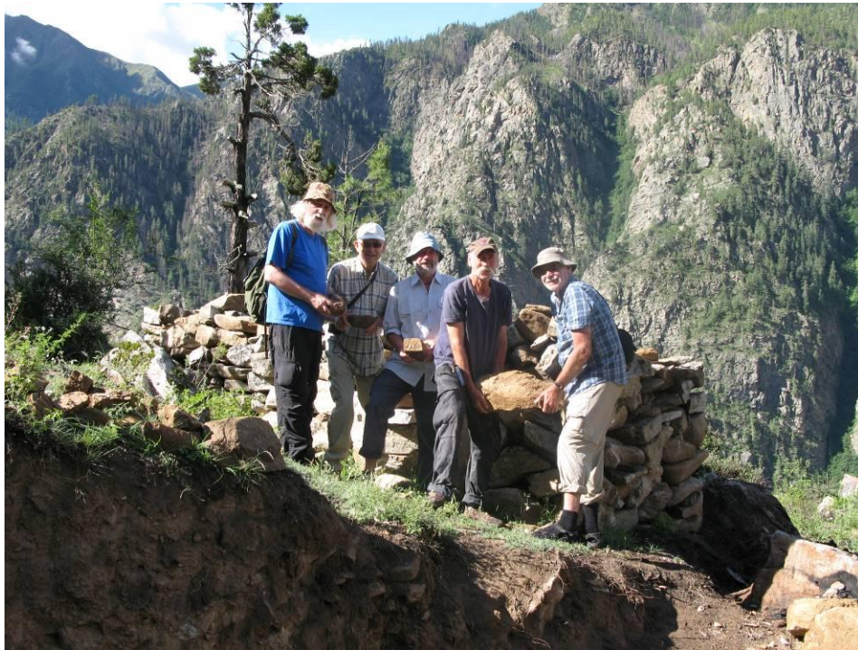
Vi samlar sten till den nya barnhemsbyggnaden.
