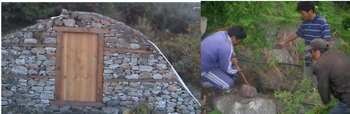
Det nya växthuset under byggnation i Humla
